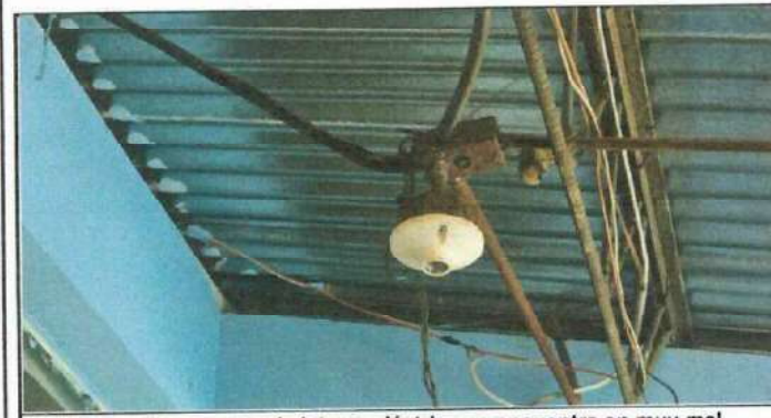
Foto 5: Se observa que el sistema eléctrico se encuentra en muy mal estado, ya que después de la inundación por las tormentas ETA/OTA no se ha podido hacer las reparaciones por lo grande que es el edificio.
